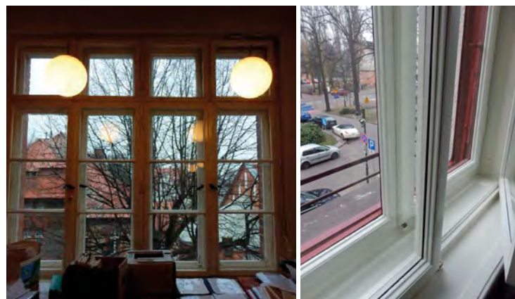
Rys. 1. Okno w budynku zabytkowym: Typ 1 – stan przed i po termorenowacji
