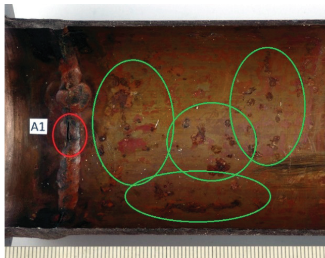
Rys. 2. Prosty odcinek rury. Kolorem czerwonym zaznaczono niepełny przetop [9], a kolorem zielonym – produkty korozji
