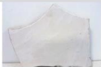
FOT. 6. Próbka tynku od strony gładzi gipsowej; fot.: autorzy
