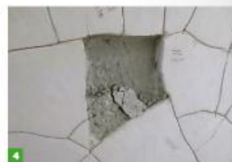
FOT. 2. Uszkodzenia tynku wewnętrznego na korytarzu komunikacyjnym klatki schodowej budynku mieszkalnego – zbliżenie; fot.: autorzy
