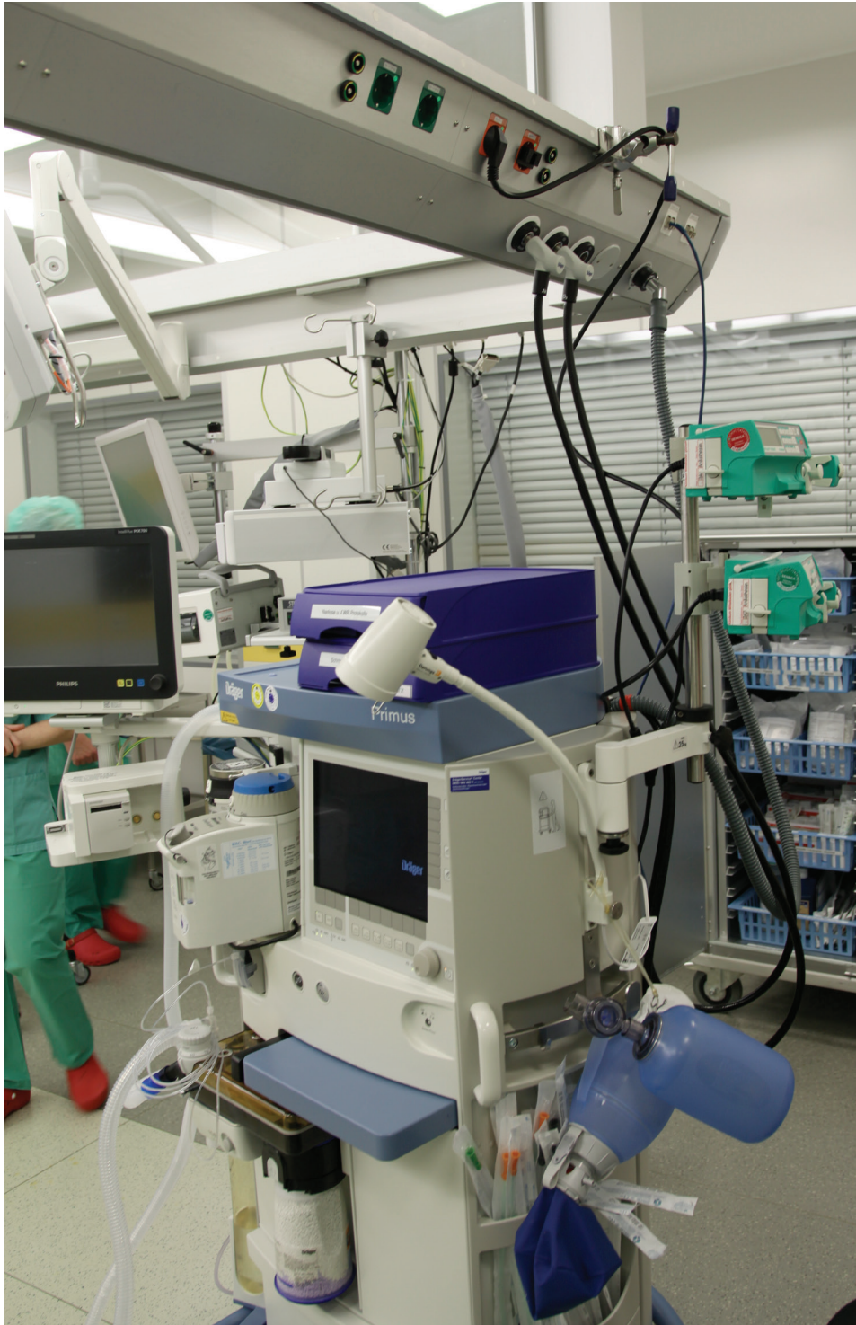
Ilustracja 5.2.2 Sala operacyjna (nagromadzenie sprzętu medycznego utrudnia skuteczną dekontaminację sali operacyjnej pomiędzy zabiegami), autor, 2016 r.
