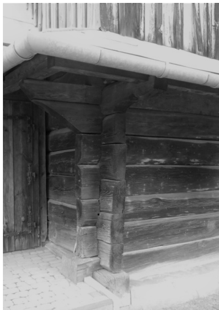
Rysunek 2. Złącze na obłap. Ściany cerkwi w miejscowości Prusie.
