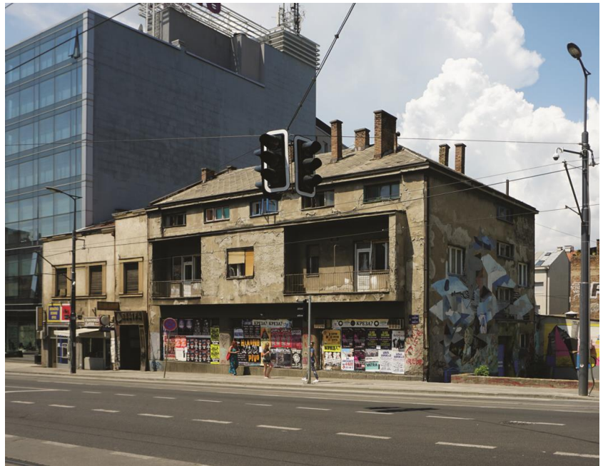
Fig. 2. The front of the building where Kvaka 22 is located. Source: phot. author Ryc. 2. Front budynku, w którym znajduje się Kvaka 22 . Źródło: fot. autor
