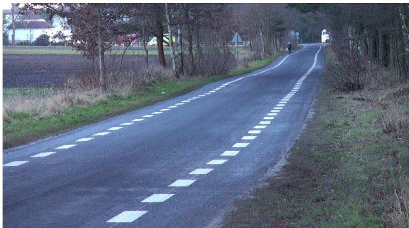
Rys. 9. Ilustracja fotograficzna odcinka „C”, w rejonie przekroju pomiarowego nr 3 w ciągu badanej drogi powiatowej nr 2628G.
