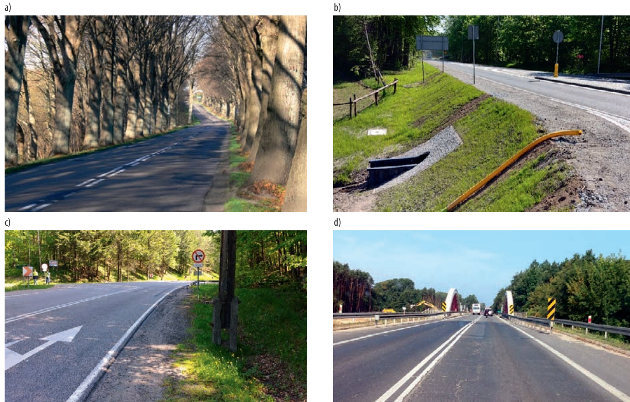
Rys. 3. Przykłady źródeł zagrożeń w otoczeniu drogi
