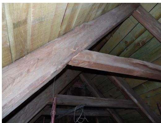
Fot. 11. Rybina – więźba dachowa. (fot. autor)
