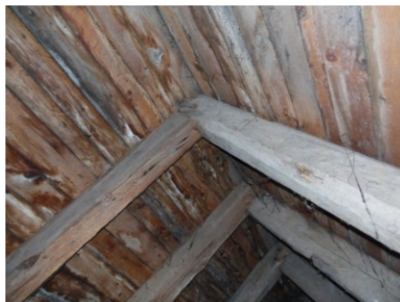
Fot. 9. Nowa Kościelnica – połączenie krokwi. (fot. autor)
