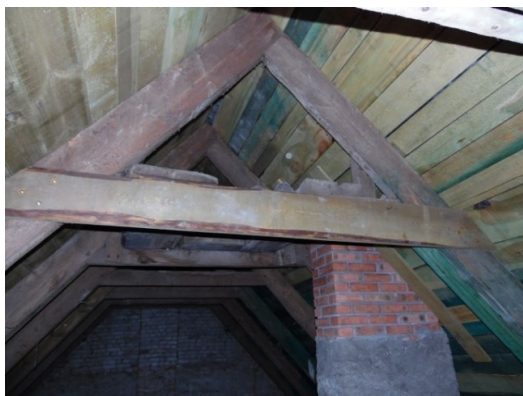
Fot. 12. Rybina – nowa jętka w wiązarze po remoncie. (fot. autor)
