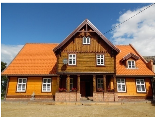
Fot. 4. Dom podcieniowy w Rybinie. (fot. autor)
