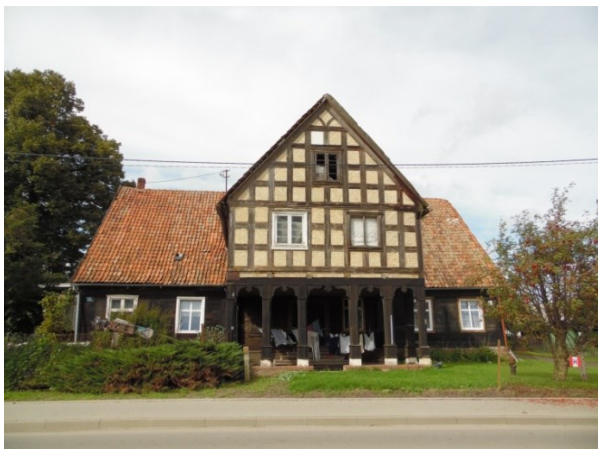
Fot. 2. Dom podcieniowy w Marynowo. (fot. autor)
