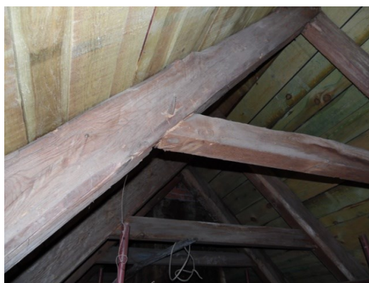
Fot. 11. Rybina – więźba dachowa. (fot. autor)
