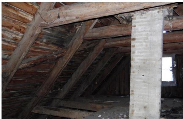
Fot. 7. Marynowy – widok na więźbę, widać dwie jętki
