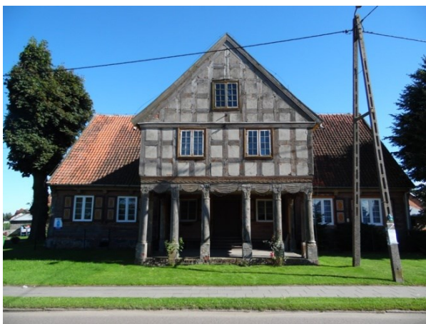
Fot. 3. Dom podcieniowy w Nowej Kościelnicy. (fot. autor)
