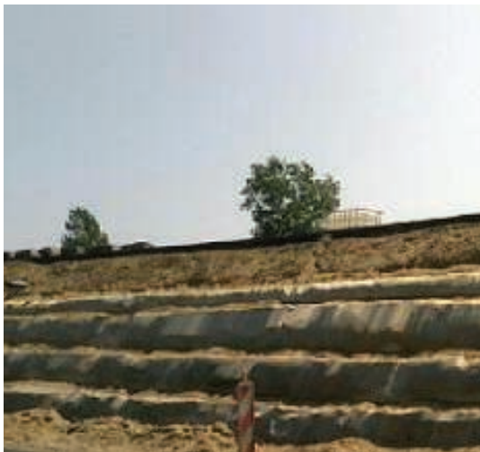
1. Wielowarstwowe ułożenie geosyntetyków w nasypie
