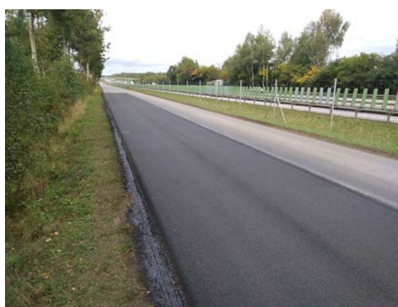
Figure 19. Galaktyczna test section after completion.
