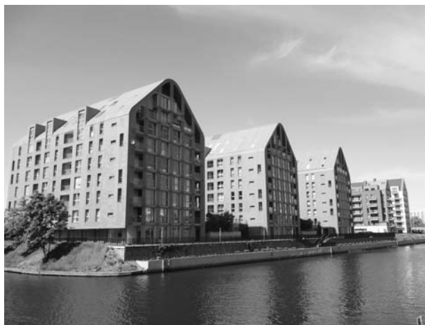
Fot. 3. Widok na fragment zespołu Aura Island (Mill-Yon Gdańsk)
