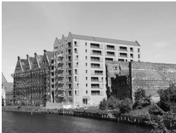
Fot. 2. Widok na fragment zespołu Waterlane Iland (L&P Company)
