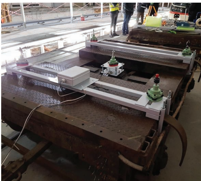
8. Montaż stelaży (wraz ze spodarkami) na wózkach pomiarowych – Zakładnia Tramwajowa Wrzeszcz
