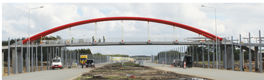
Rys. 2. Widok z boku kładki nad drogą S8
