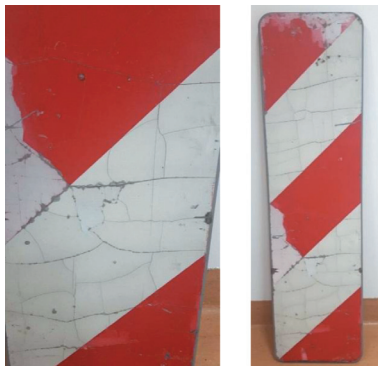
Fot. 5. Znak U-54c po 10 latach eksploatacji
