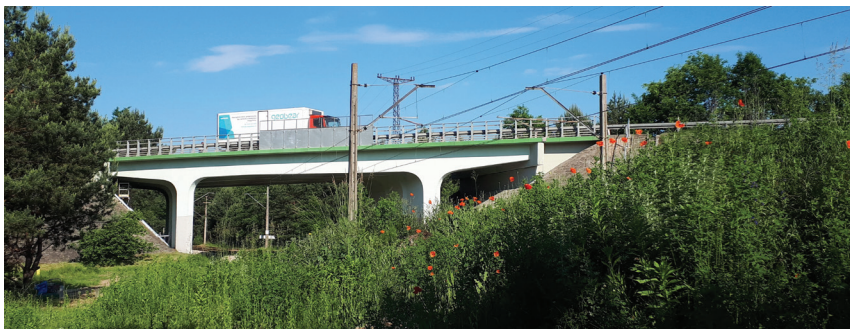
Fot. 1. Widok ogólny (Geobear Sp. z o.o.)
