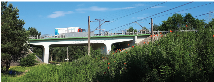
Fot. 1. Widok ogólny (Geobear Sp. z o.o.)
