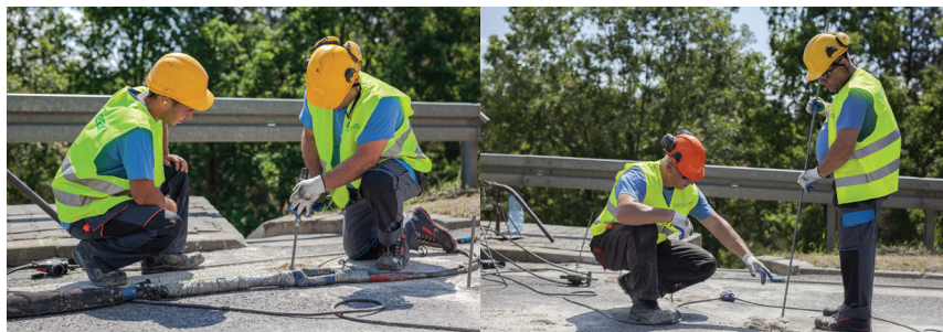
Fot. 5. Wzmocnienie gruntu pod przyczółkami wiaduktu drogowego na drodze krajowej nr 12 przez iniekcje geopolimerowe (Geobear Sp. z o.o.)
