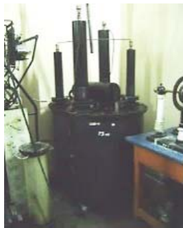
Rys. 8. Transformator 150 kV firmy Siemens-Schuckert znajdujący się obecnie w gmachu głównym Politechniki Lwowskiej [6]
