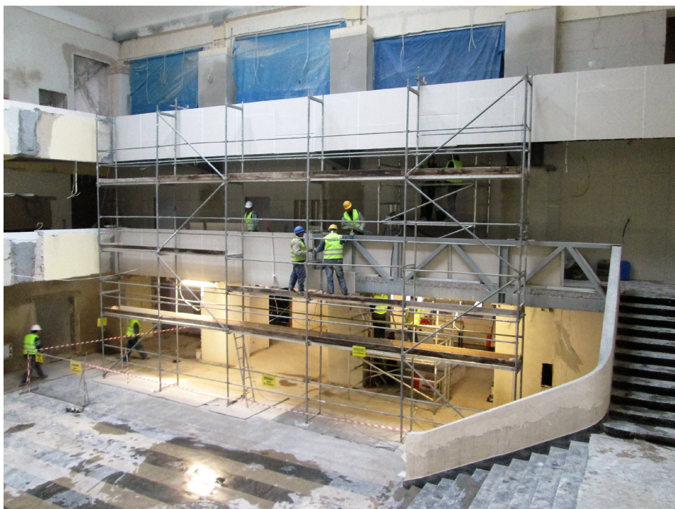
Ryc. 4 Gdynia. Dworzec Morski, wykańczanie konstrukcji stalowej galerii komunikacyjnych w wnętrzu holu głównego, 2014 r., fot. R. Hirsch
