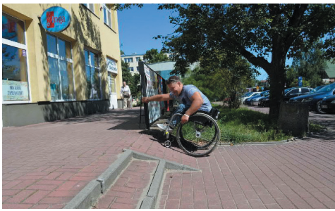
Rys. 4. Przykład nieprawidłowości stosowania urządzeń dla osób ze szczególnymi potrzebami – zbyt duże pochylenie pochylni Źródło: [41]
