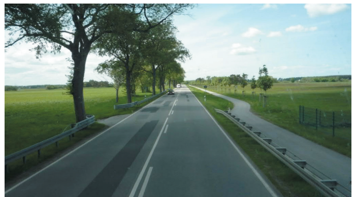
Rys. 12. Usytuowanie drogi dla pieszych wzdłuż drogi zamiejskiej lub ulicy poza barierą bezpieczeństwa i poza rowem
