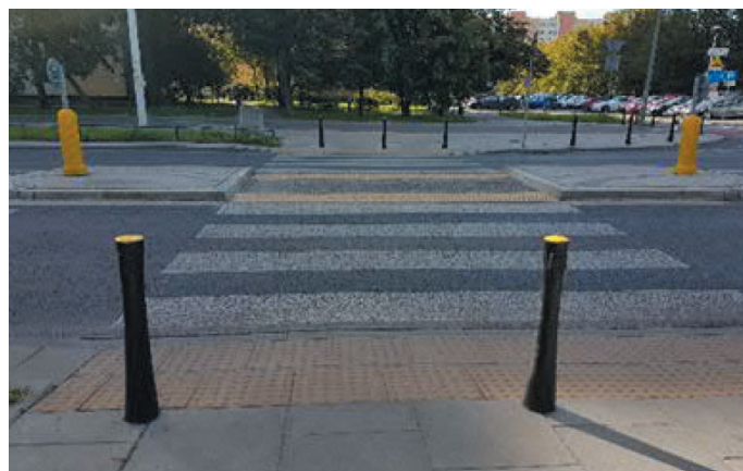
Rys. 25. Przykład stosowania pasów ostrzegawczych w Warszawie Źródło: fotografia własna
