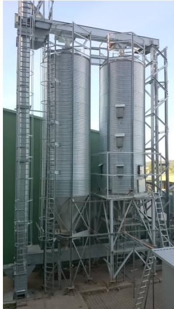
Rys. 4.5. Stanowisko badawcze silosów (silos do przechowywania materiału z lewej strony, silos pomiarowy z prawej strony) [Wójcik i inni 2017]
