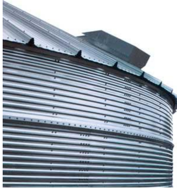
Rys. 3.6. Zmodyfikowany profil blachy trapezowej firmy BEHLEN [15]
