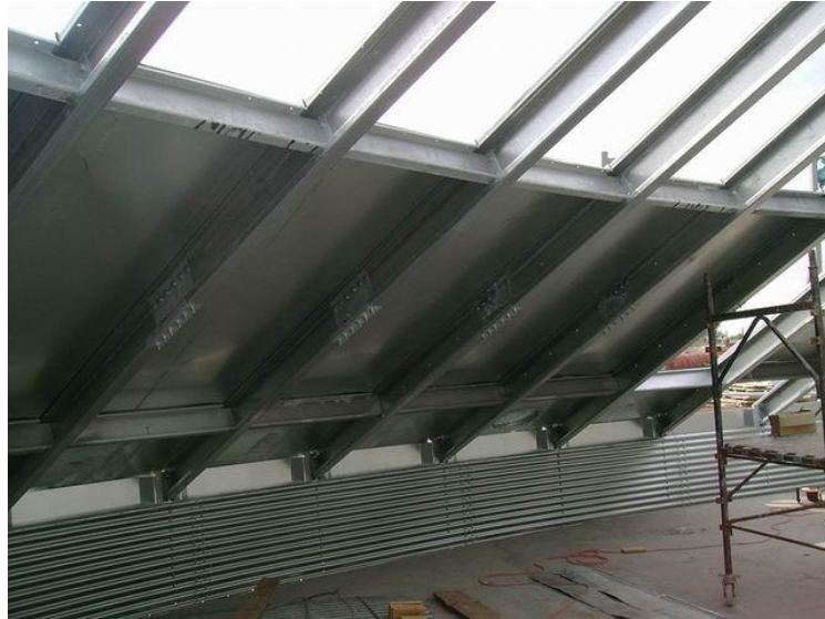
Rys. 3.13. Konstrukcja dach krokwiowy w fazie montażu [I1]
