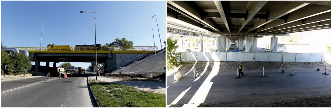
Rysunek 6.25 Widok wiaduku Brańskiego z boku oraz od spodu konstrukcji.
