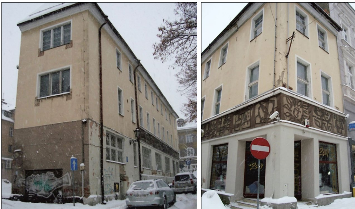
Ryc. 1. Widok budynku położonego w Olsztynie przy ul. Staromiejskiej: a) elewacja tylna, b) elewacja frontowa; fot. M. Zielińska 2012. Fig. 1. View of the building located in Olsztyn at Staromiejska Street: a) rear elevation, b) front elevation; photo by M. Zielińska 2012.
