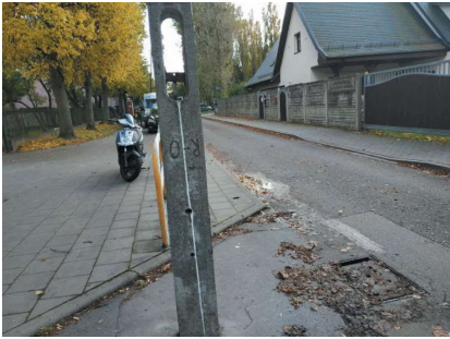
Fot. 7. Słup energetyczny ograniczający widoczność (fotografia – zasoby własne autorek)
