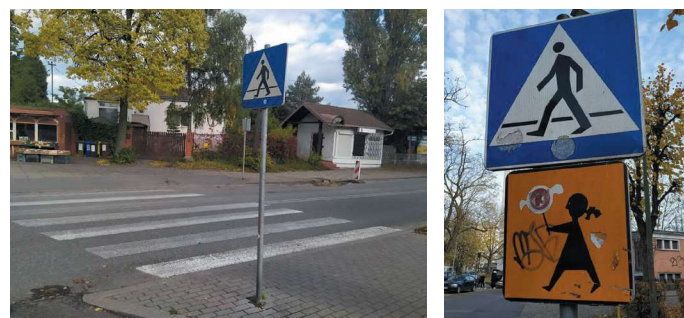
Fot. 2. Zły stan oznakowania poziomego oraz brak urządzeń dla osób niewidzących i niedowidzących (fotografia – zasoby własne autorek)
