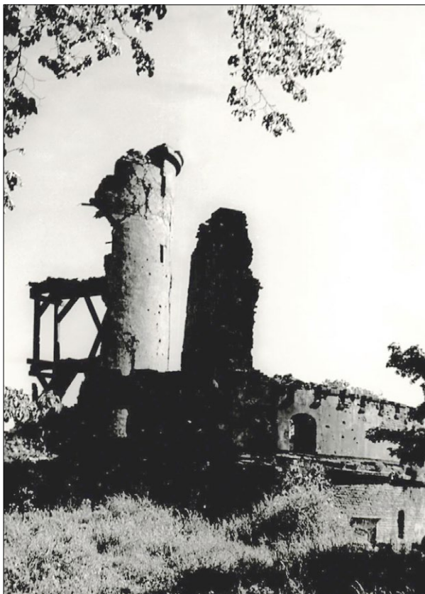
Ryc. 2. Wieża po zniszczeniach wojennych – stan w 1953; fot. J. Ciemnolowski; Źródło: Wydział Architektury Politechniki Gdańskiej.
