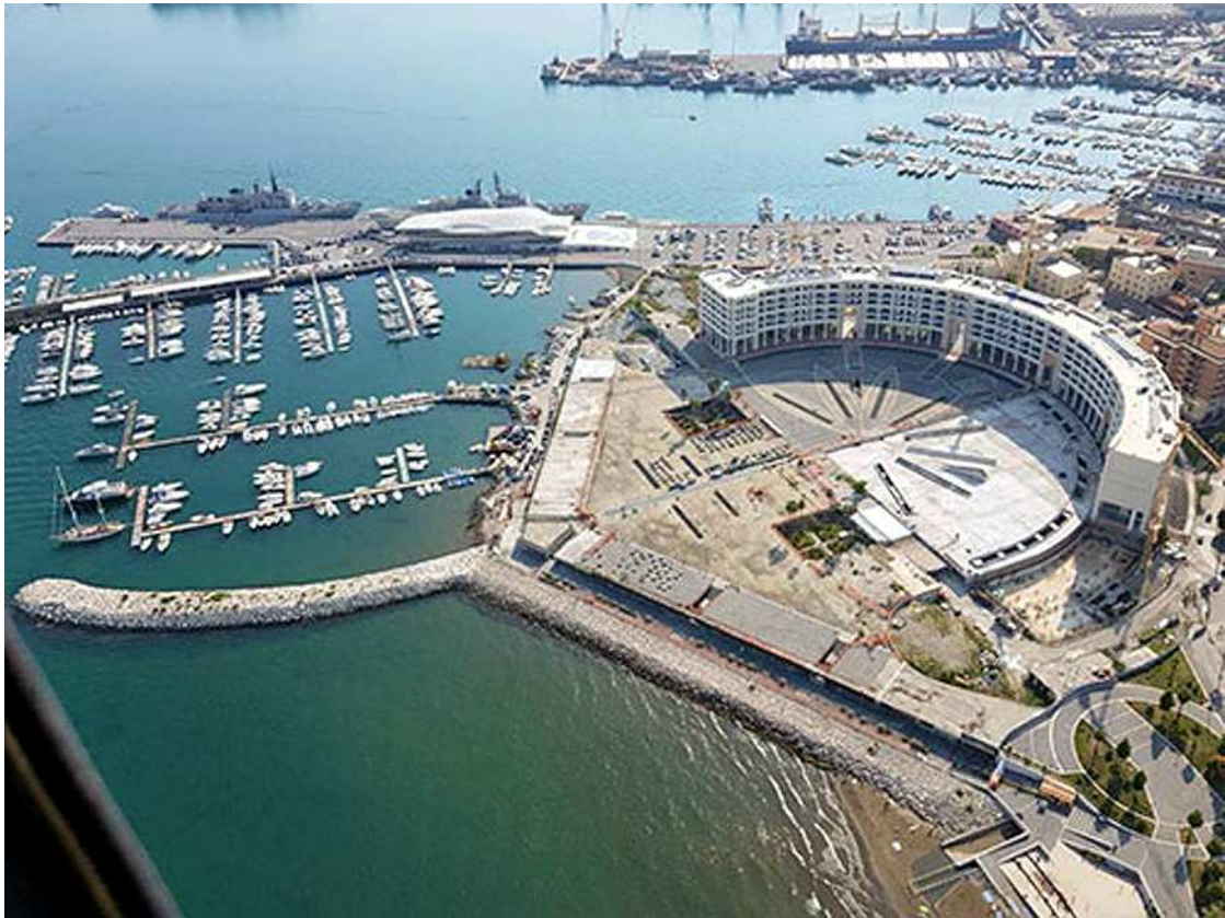
Fot. 28. Salerno – Piazza della Libertà w trakcie budowy w roku 2018.
