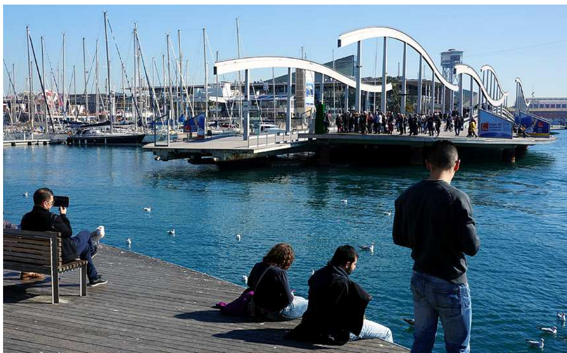
Fot. 64. Rozsuwane wrota w Rambla de Mar. Przechodnie czekają na zamknięcie mostu i przyglądają się przepływającym jachtom. Fot. Katarzyna Rembarz (12.02.2015)
