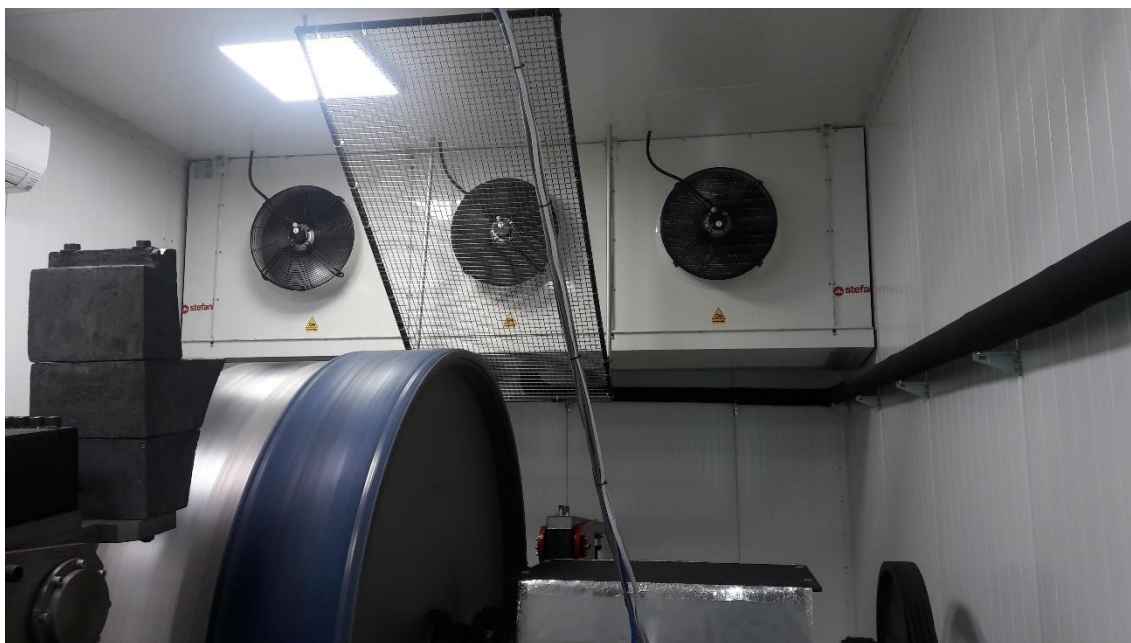
Rysunek 16. Wymiennik ciepła stosowany w laboratorium Zespołu Pojazdów Politechniki Gdańskiej (materiał własny)
