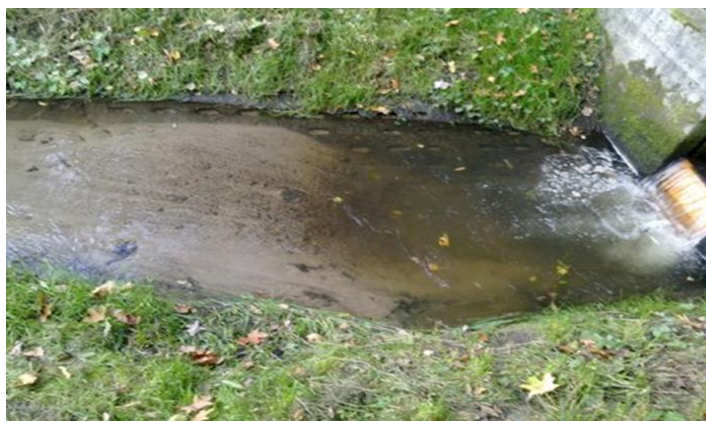
Rys. 5.41. Odpływ z piaskownika do zbiornika retencyjnego w okresie bezdeszczowym po czyszczeniu zbiornika retencyjnego (fot. Marzena Stosik)
