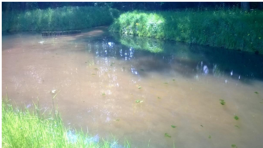
Rys. 5.44. Dopływające wody potoku wraz z zawiesiną ominą kierownicę – palisadę wybierając najkrótszą drogę (fot. M. Gajewska)
