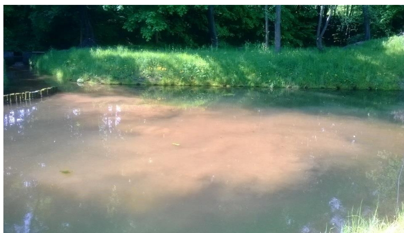
Rys. 5.43. Niezidentyfikowany dopływ zawiesiny do zbiornika w systemie hydrofitowym na potoku Swelina (fot. Magdalena Gajewska)
