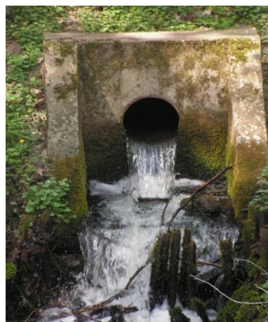
Rys. 3.11. Widok na: a) przelew do złoża hydrofitowego i b) odpływ ze studni kontrolnej po złożu hydrofitowym (fot. Marzena Stosik)
