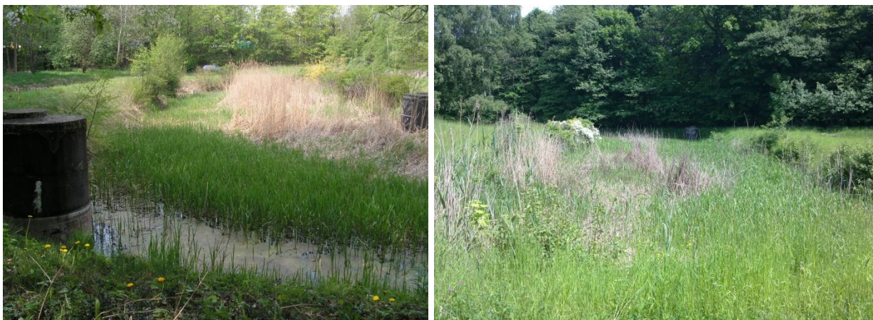
Rys. 3.5. Złoże hydrofitowe z podpowierzchniowym poziomym przepływem (SS HF) na potoku Swelina (fot. Marzena Stosik)
