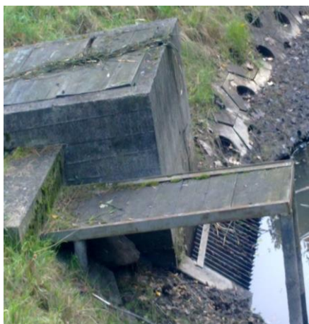
Rys. 3.11. Widok na: a) przelew do złoża hydrofitowego i b) odpływ ze studni kontrolnej po złożu hydrofitowym (fot. Marzena Stosik)
