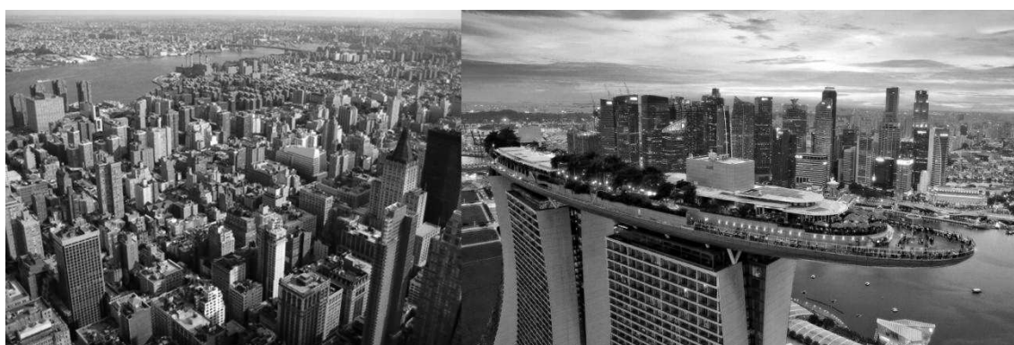
Rysunek 3.12. a) Centrum Nowego Jorku, Stany Zjednoczone. Widok z lotu ptaka. (z lewej). ( http://new.driftwooddreaming.co.uk/wp-content/uploads/2010/11/NY-BW-sky-line-3.jpg ) b) Centrum Singapuru. Widok z lotu ptaka. (z prawej). ( http://exploresingapore.sg/wp-content/uploads/2016/06/Teo-Soon-Haur-Aerial-Photography-Singapore-MBS-Skypark-1.jpg ).
