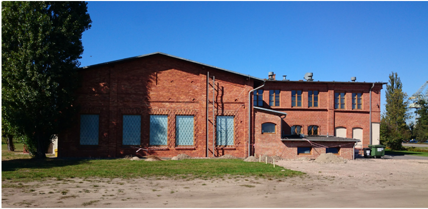
Fot. 1. Widok budynku Sali BHP z pokazaniem pomieszczenia kotłowni
