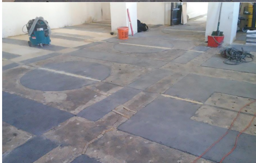
Fot. 1. Układanie zróżnicowanych kolorystycznie mieszanek lastrico i uzupełnianie ubytków na poddanej rewitalizacji posadzce w obiekcie zabytkowym [M1]
