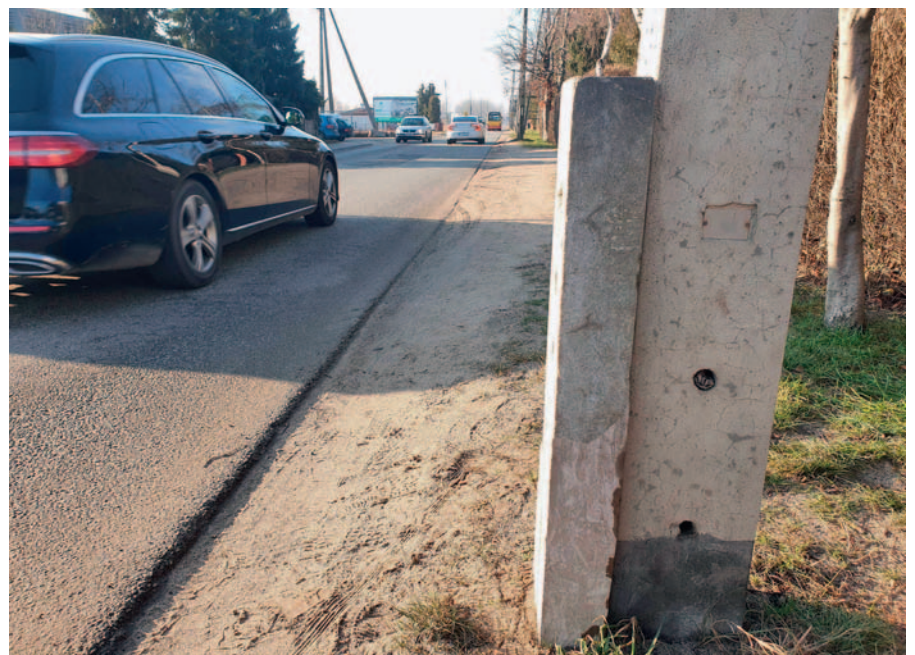
Fot. 3. Widok na próbkę żelbetową z zatopionymi prętami z protektorem [źródło: Marcin Majewski]
