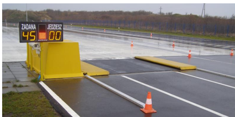
Rys.D.1. Widok „płyty dynamicznej” – Autodrom Pomorze
