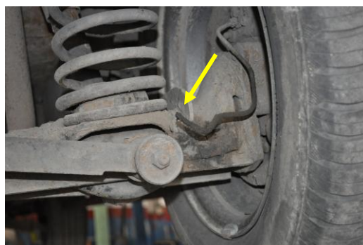
Rys. 4.60. Zaślepiony przewód hamulcowy znajdujący się przy tylnym prawym kole
