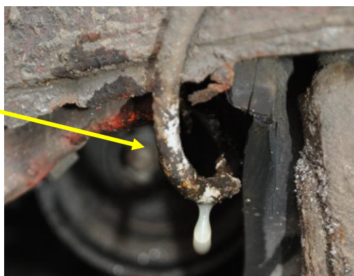
Rys. 4.46. Widoczny wyciek płynu hamulcowego z metalowego przewodu
