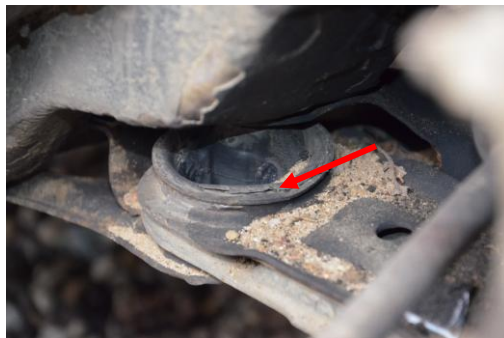
Rys. 4.27. Pęknięcia gumy w tulei metalowo-gumowej wahacza przedniego
