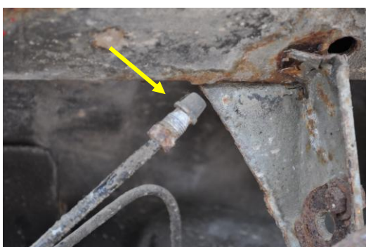
Rys. 4.89. Zaślepiony przewód doprowadzający płyn do tylnego prawego hamulca
