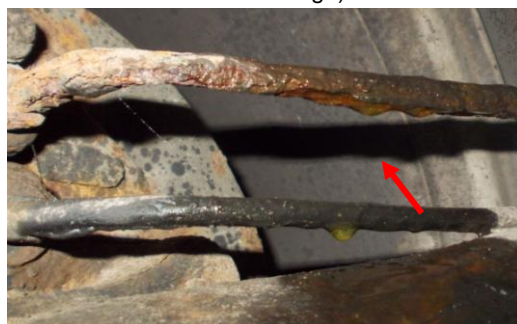
Rys. 5.7. Fragment skorodowanego przewodu hamulcowego z którego wycieka płyn
