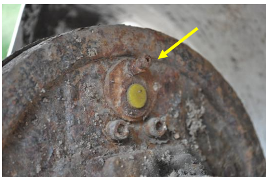
Rys. 4.87. Brak przewodu hamulcowego przy tylnym lewym hamulcu bębnowym
