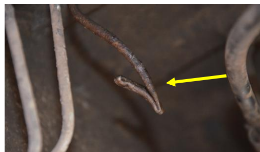
Rys. 4.52. Zaślepiony przewód hamulcowy, metalowy przy tylnym lewym kole
