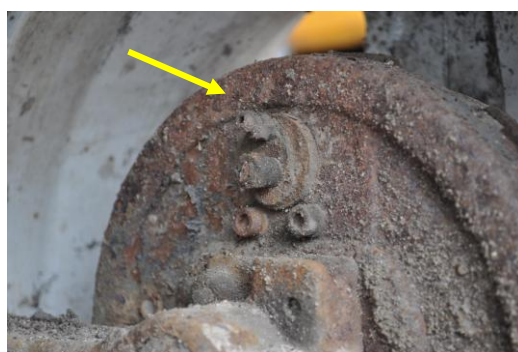
Rys. 4.90. Brak przewodu hamulcowego przy tylnym prawym hamulcu bębnowym
