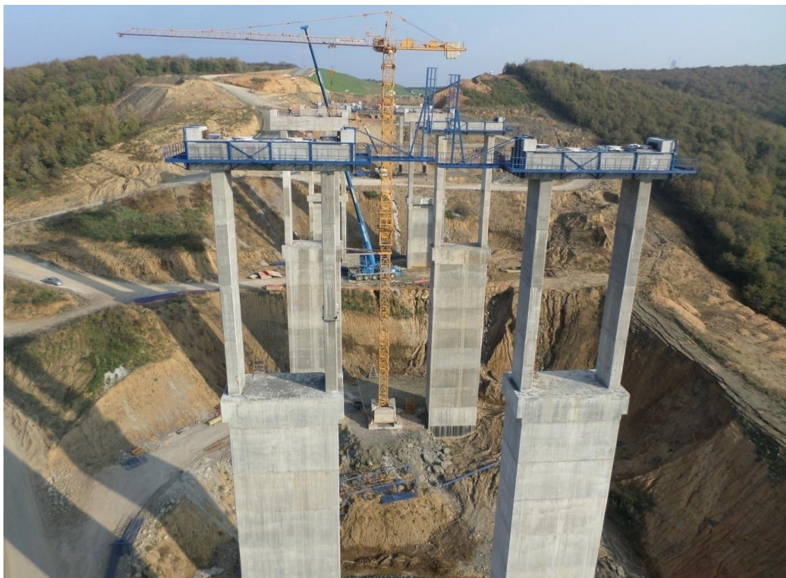
Rys. 38 Zdjęcie z budowy wiaduktu V17 (wrzesień 2014)
