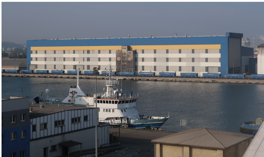
Fot. 6. Elewacja głównej części Olejarni z dobudowaną nową halą montażową, 2019 r., fot. R. Hirsch
