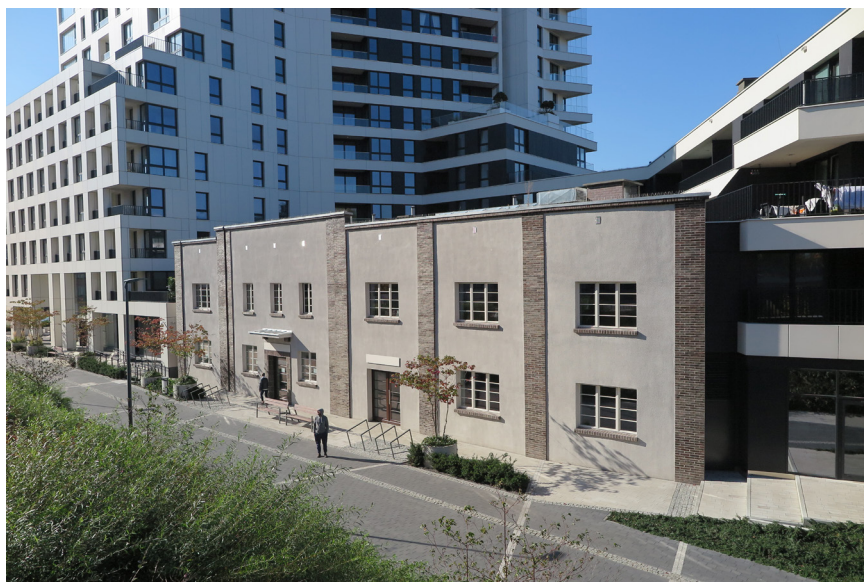
Fot. 7. Elewacje budynku firmy Hartwig przy ul. Węglowej 22 (niska część z pionowymi pasmami), pozostawione w strukturze nowej zabudowy mieszkaniowej przy ul. Węglowej, 2021 r., fot. K. Gieldon
