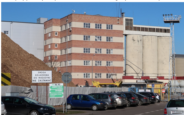
Fot. 2. Budynek produkcyjny Łuszcarni Ryżu z charakterystycznymi biało-czerwonymi pasami, z dobudowanymi współczesnymi silosami, 2021 r., fot. R. Hirsch
