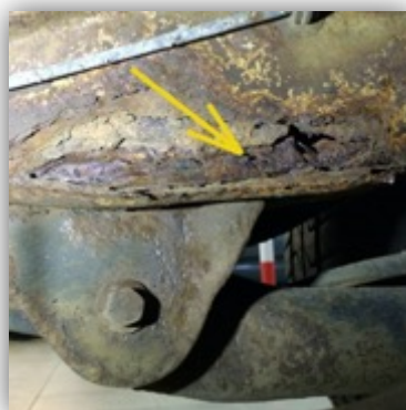
Rys. 2.8. Nadmierna korozja elementów konstrukcyjnych
