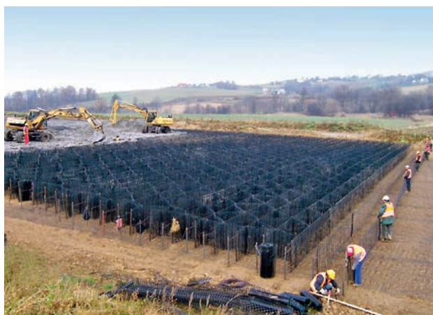
Fot. 2. Konstrukcja geomateraca
