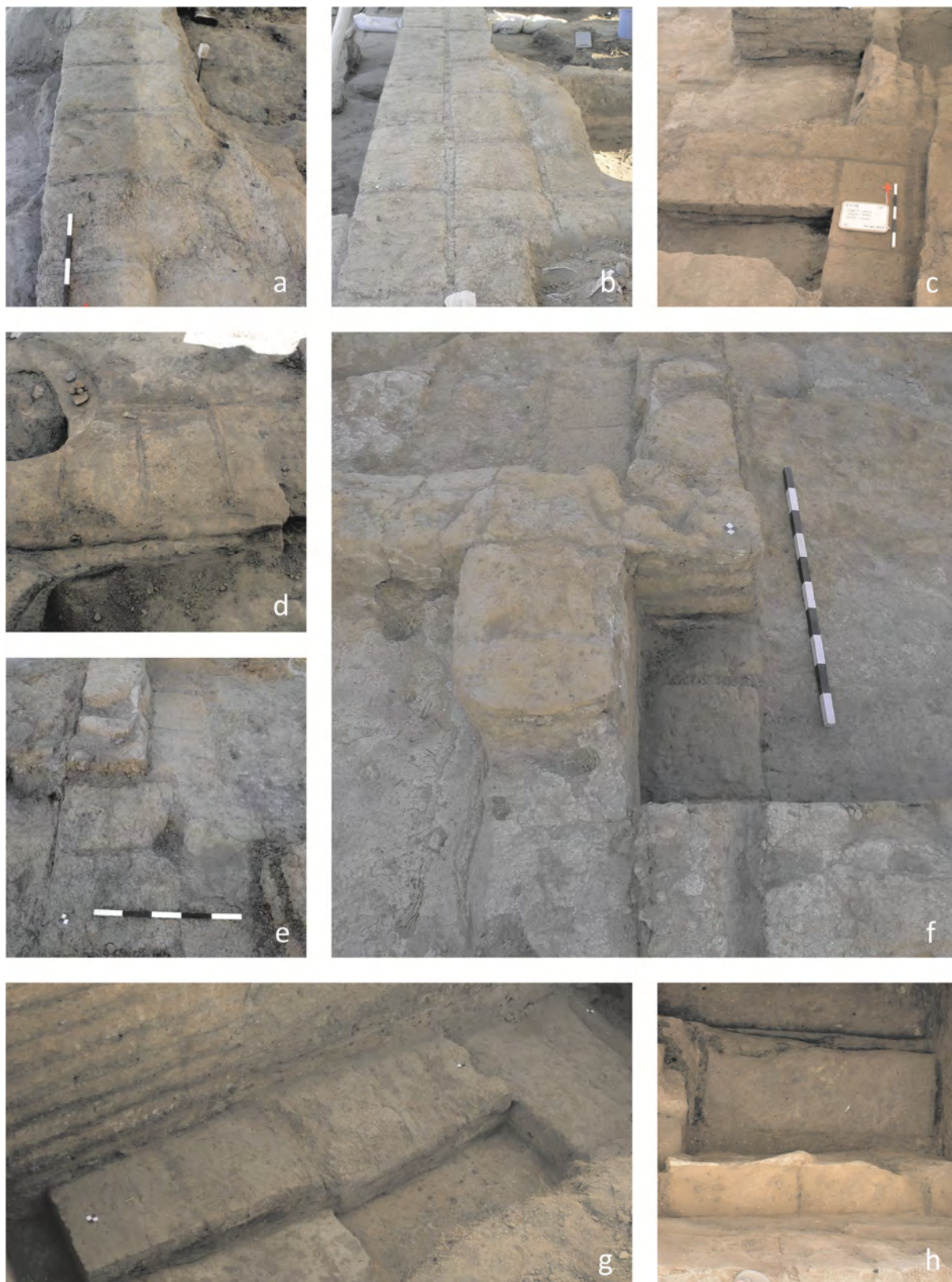
Rycina 29. Przykłady złożonych fundamentów: a-b) F.2882 w domu B.74-B.62/B.61 (fot. A. Leszczewicz), c) F.2281a/F.2284 w budynku B.74-B.62/B.61 (fot. A. Leszczewicz), d) F.2893 w domu B.95 (fot. A. Golański), e-f) F.7694a/F.8082a w budynku B.142 (fot. M.Z. Barański), g) F.2284/F.3579 w domu B.74-B.62/B.61 (fot. M.Z. Barański) oraz h) F2878 budynku B.81 (fot. A. Leszczewicz).
