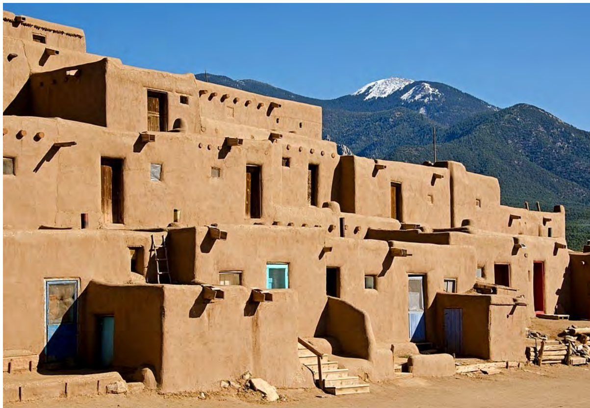
Rycina 19. Widok na charakterystyczną zabudowę pueblo w Taos w Nowym Meksyku w Stanach Zjednoczonych Ameryki (archiwum taospueblo.com).
