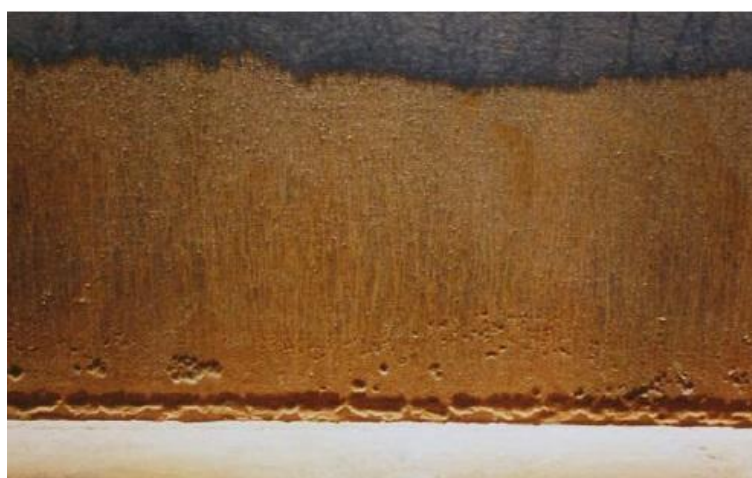
Rys. 1.15. Uszkodzenia korozyjne płaszcz zbiornika ( V = 12\,000\text{ m}^3 ) w strefie połączenia płaszcz z dnem [12]
