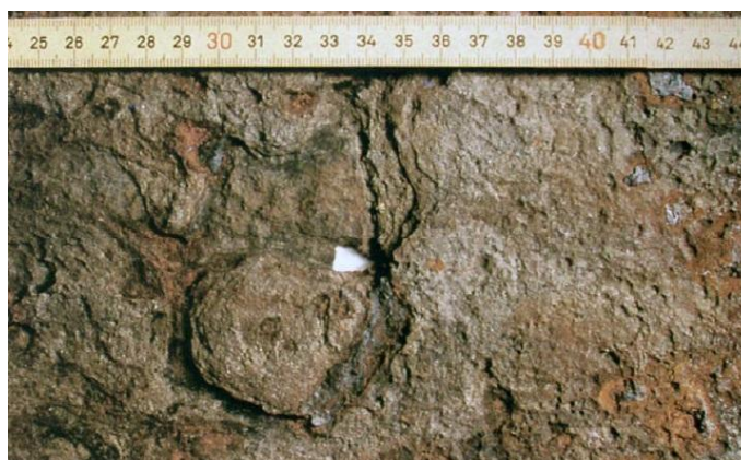
Rys. 1.19. Wżery korozyjne pod osadowe na dnie zbiornika, wywołane bakteriami redukującymi siarczany [12]
