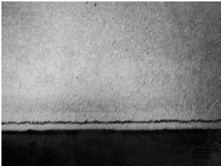
Rys. 1.13. Wżer korozyjny w strefie wpływu ciepła spoiny łączącej pierwszy pierścień płaszcza z dnem zbiornika
