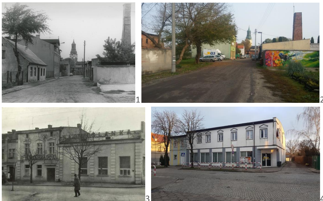
Fot. III. 12. Porównanie stanu zabudowy z okresu opracowania studium (1991) z obecnym (2017), fot. autorka
