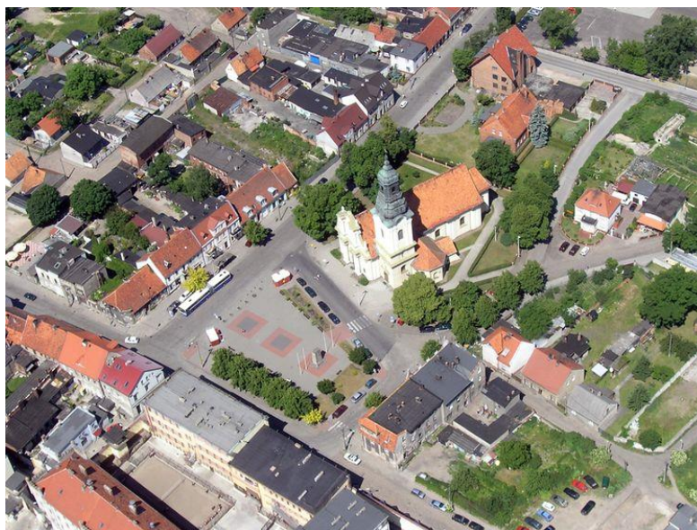
Fot. III. 9. Rynek w Starym Fordonie. Widoczny Rynek wraz z kościołem Św.Mikołaja oraz główne ulice- Wyzwolenia biegnąca na północ wzdłuż zachodniej pierzei oraz Bydgoska, przechodząca w ulicę Sikorskiego wzdłuż pierzei południowej Rynku, materiały Urzędu Miasta Bydgoszczy.
