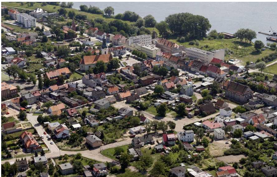
Fot. III. 26. Stary Fordon – widok od północnego – zachodu od strony Nowego Fordonu, aut. M. Chełminiak
