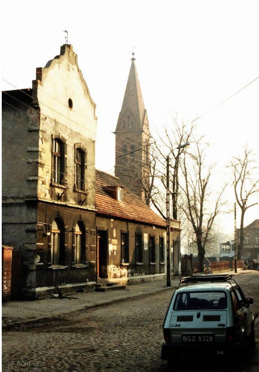
Ryc. II. 12. Budynek dawnego magistratu rozebrany w latach 80-tych, fot. ze zbiorów Romana Brzezińskiego
