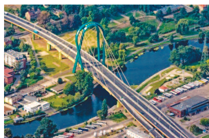
Fot. 1. Most Uniwersytecki w Bydgoszczy Źródło: Gotowski.pl Photo 1. The University Bridge in Bydgoszcz
