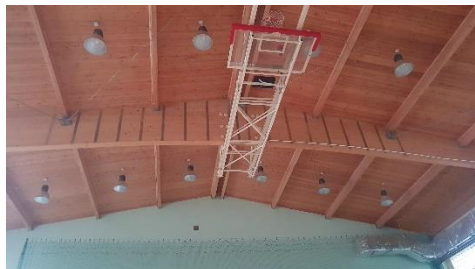
Rys. 4. Wzmocnienie i zabezpieczenie dźwigara dachowego z drewna klejonego w sali sportowej w osi 2: szczegółowe rozwiązanie projektowe – strona: a) lewa, b) prawa, stan zrealizowany - strona: c) lewa, d) prawa
