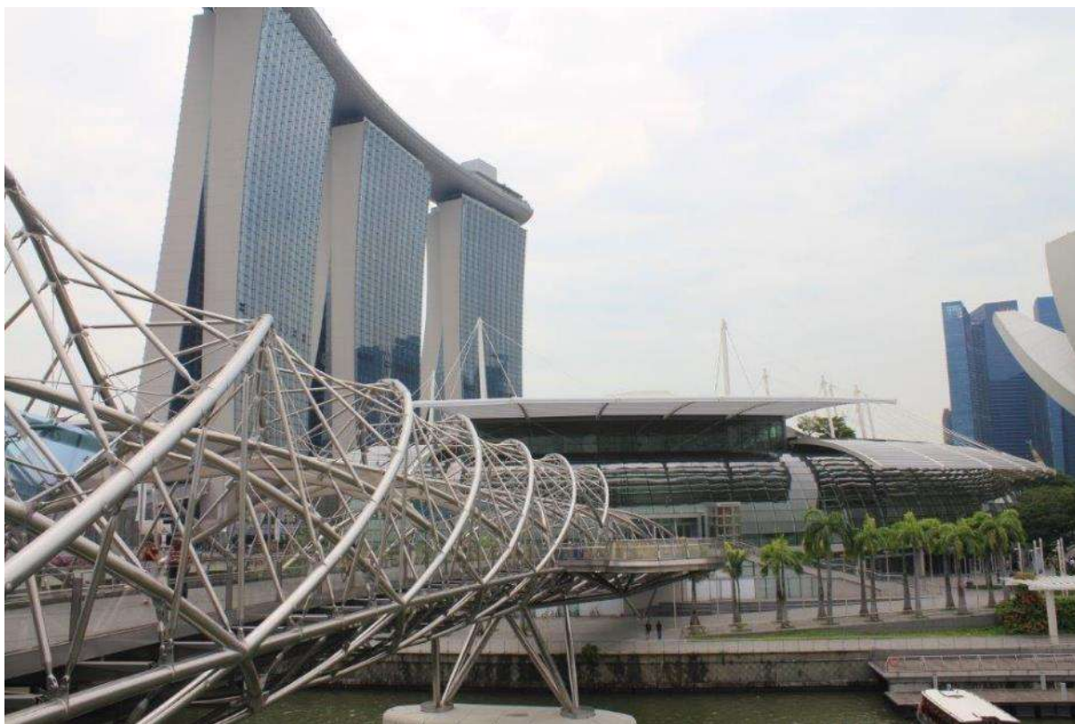
Ryc. 17 Helix Bridge, Singapur – innowacyjna forma kładki dla pieszych (fot. M. Izidor)
