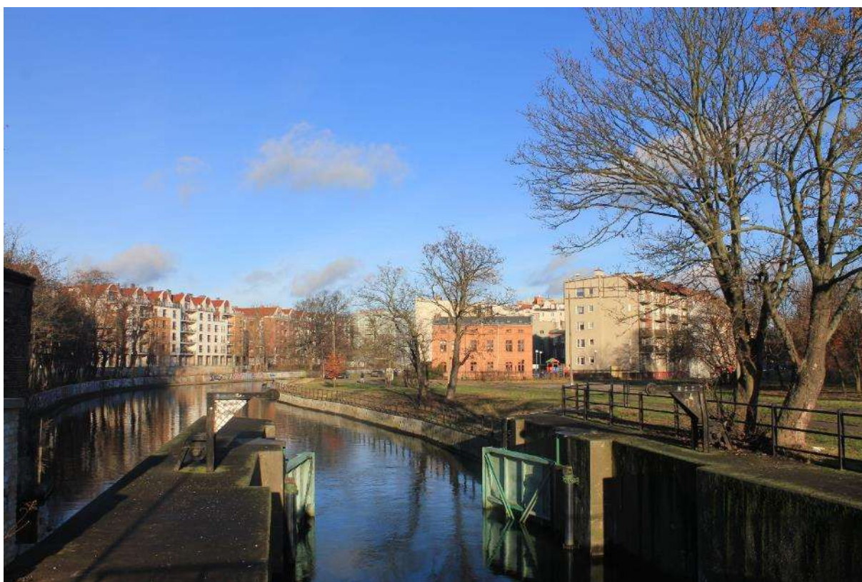
Ryc. 68 Kanał Nowej Motławy, rejon Kamiennej Śluzy, Gdańsk (fot. M. Izydor)
