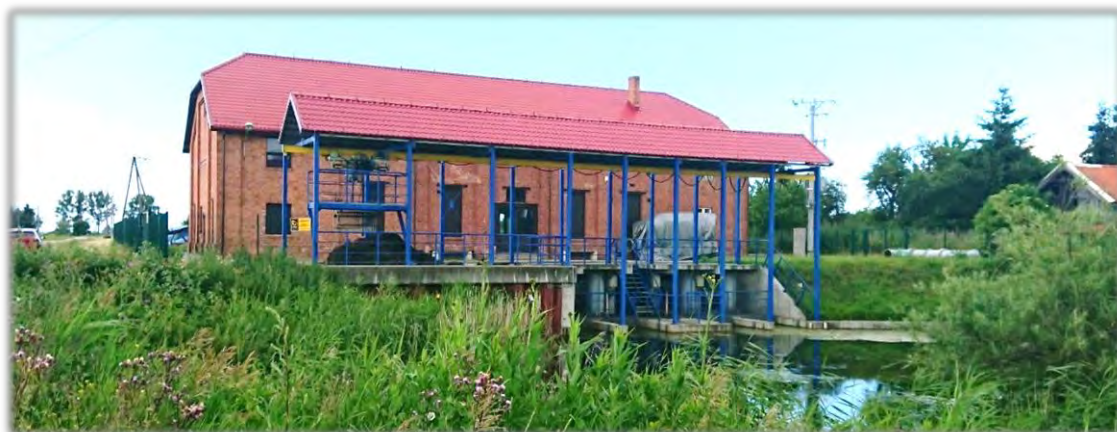
Ryc. 5.13. Stacja pomp nr 6W Grochowo, fot. A. Rubczak (2020).
