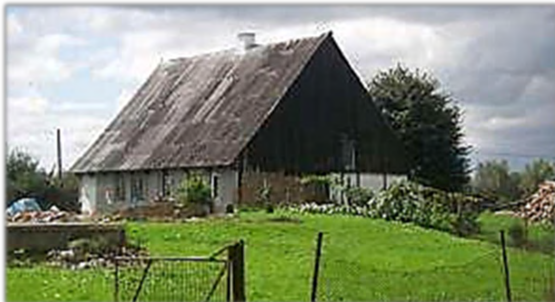
Ryc. 5.2. Budynek na terpie – zagroda holenderska w typie kątowym (budynki gospodarcze rozebrano) we wsi Żurawiec
