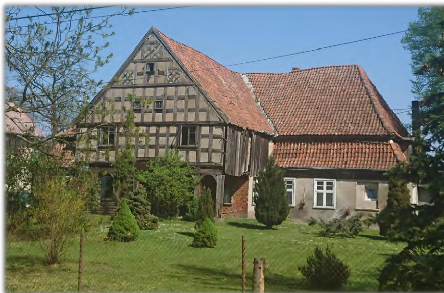
Ryc. 2.13. Dom podcieniowy w Steblewie – stan budynku w roku 2019 Źródło: fot. A. Rubczak, 2018
