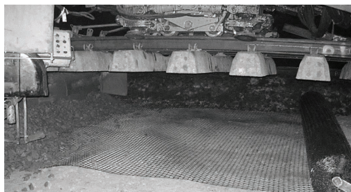
13. Układanie georusztu Tensar TriAx za pomocą maszyny AHM
