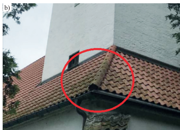
Elementy degradacji w miejscach zacienionych i nieodrestaurowanych: a) widok chmury punktów na zdegradowanej dachówce; b) dach porośnięty mchem Elements of degradation in shaded and unrestored places: a) view of a point cloud on a degraded tile; b) moss roof growth
