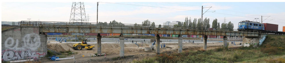
Rys. 1. Widok ogólny na most
