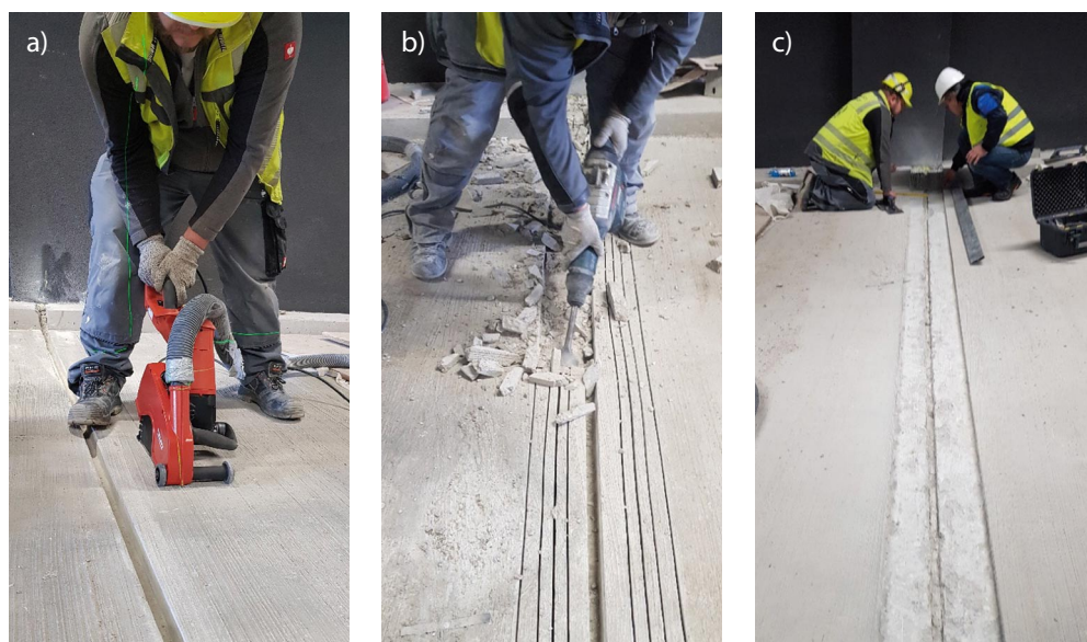
Rys. 10. Etapy naprawy dylatacji konstrukcyjnej: a) trasowanie bruzdy, b) wycięcie i wykucie bruzdy, c) pogłębienie i oczyszczenie bruzdy [26]
