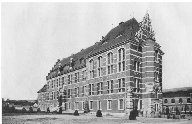
Rys.1. Budynek Instytutu Elektrotechnicznego, 1904 (zbiory Sekcji Historycznej PG)
