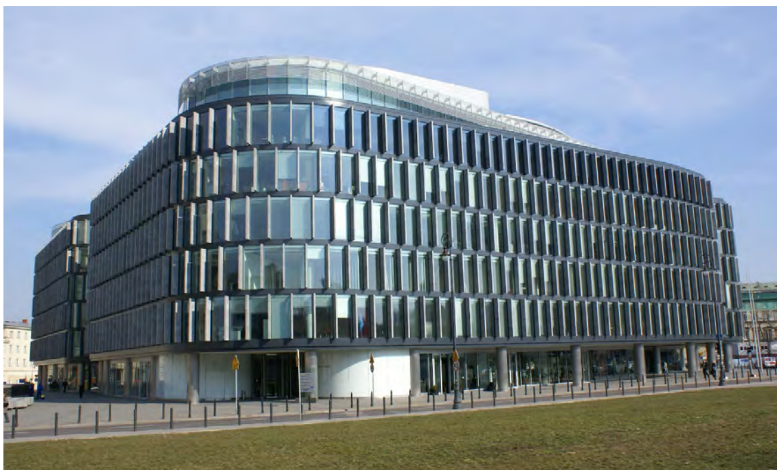
Il. 72. Budynek Metropolitan przy Placu Piłsudskiego w Warszawie Źródło: materiały własne, Grupa 5 Architekci.
