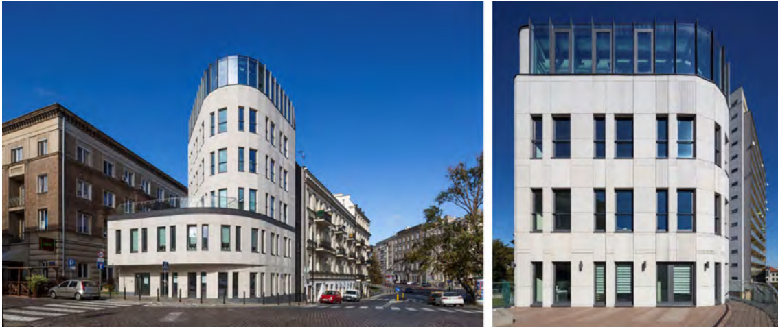
Il. 91, il. 92. Budynek biurowy przy ul. Kopernika w Warszawie, fot. Marcin Czechowicz Źródło: materiały własne Grupa 5 Architekci.
