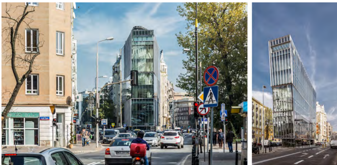
Il. 93, il. 94. Budynek biurowy przy ul. Piękiej w Warszawie Źródło: materiały własne Grupa 5 Architekci.
