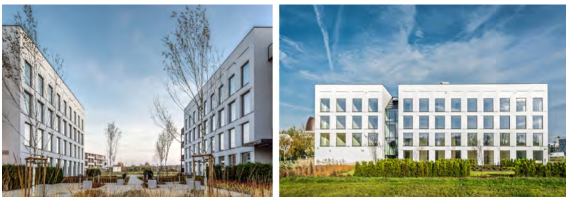
Il. 34, il. 35. Mikroapartamenty przy ul. Ledóchowskiej. Warszawa, 2015 Źródło: materiały własne Grupa 5 Architekci.
