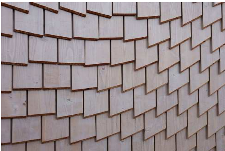
Rys.8.6.a: Zbliżenie na elewację z gontu
