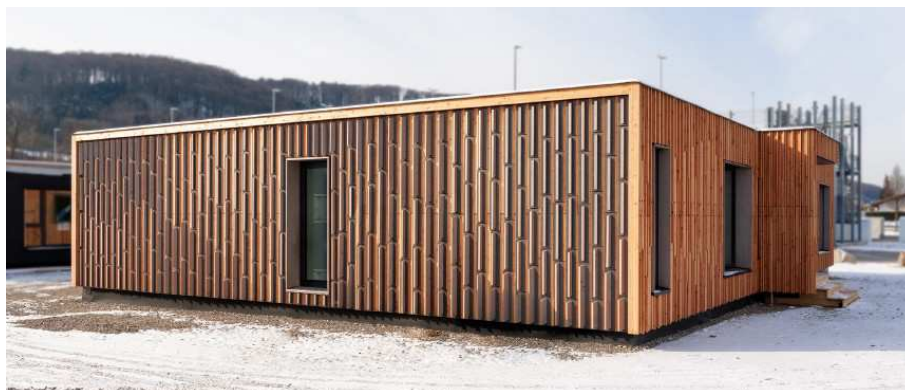
Rys.8a: Demonstracja zastosowania wyników badań projektu CoDeFa na elewacjach tymczasowego budynku biurowego
